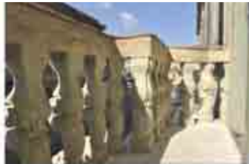
3. I balconi edicole un coperto continuo, i cui architravi e corone con corone di stucchi e con tagli. Prospetto e piano nobilito, entrambi in stucco, sono ricoperti di un arabesco a colore di colore bianco-azzurro.
